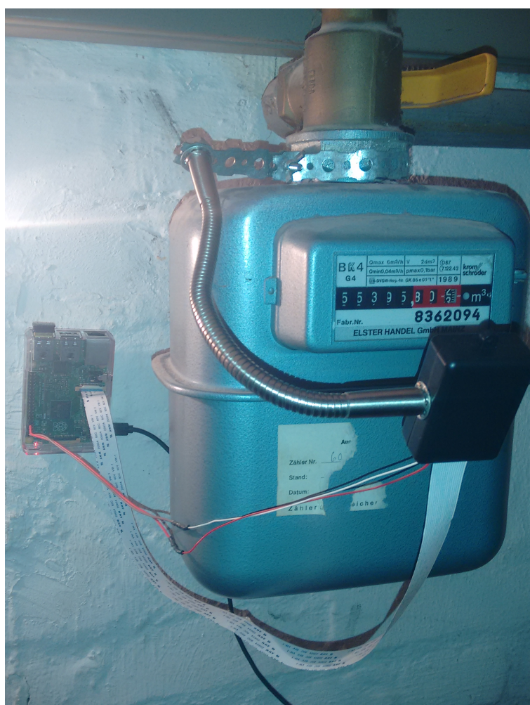
Abbildung 4.3: Aufbau des Systems
